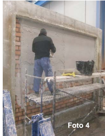
Fotos 3 y 4: Aplicación revestimiento de yeso
