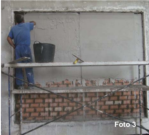
Fotos 3 y 4: Aplicación revestimiento de yeso
