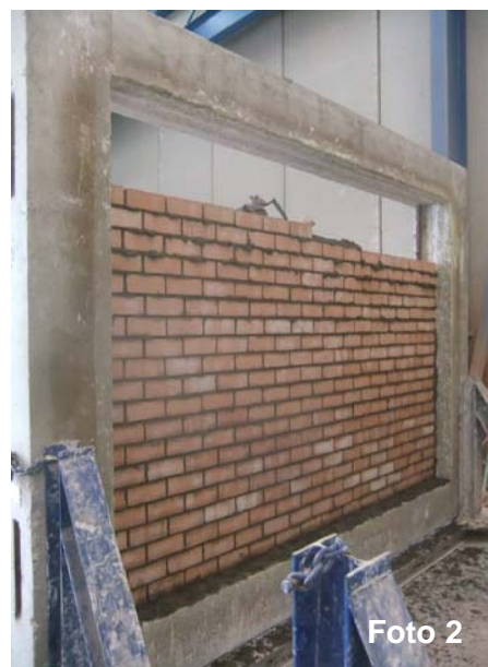
Fotos 1 y 2: Montaje de pared
