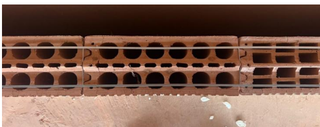
Figura 2.4: Armadura de tendel
